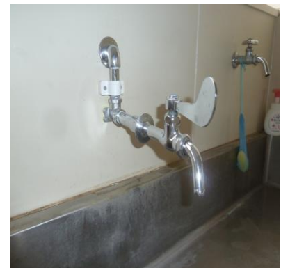
<手洗い場の改修>
